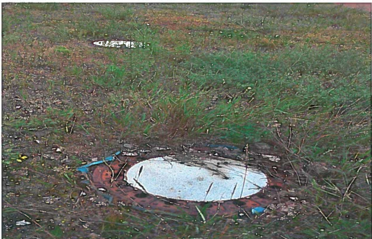
Gullys im Sportfeld nach dem Einbau der Rigolen
